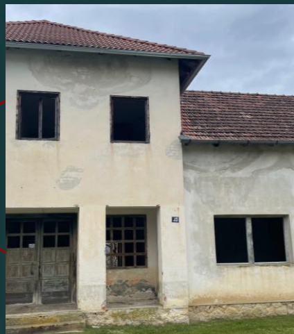
Rekonstrukcija vatrogasnog doma u Siraču (unutrašnjost) 47.100,00
